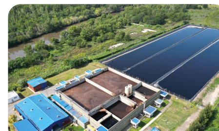
Tratamiento de Líquidos Lixiviados
